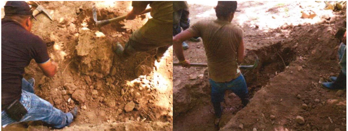
Figura 82. Excavación de la muestra para el estudio de suelos
