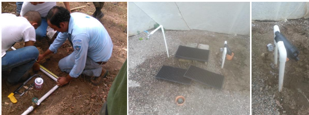
Central de riego
