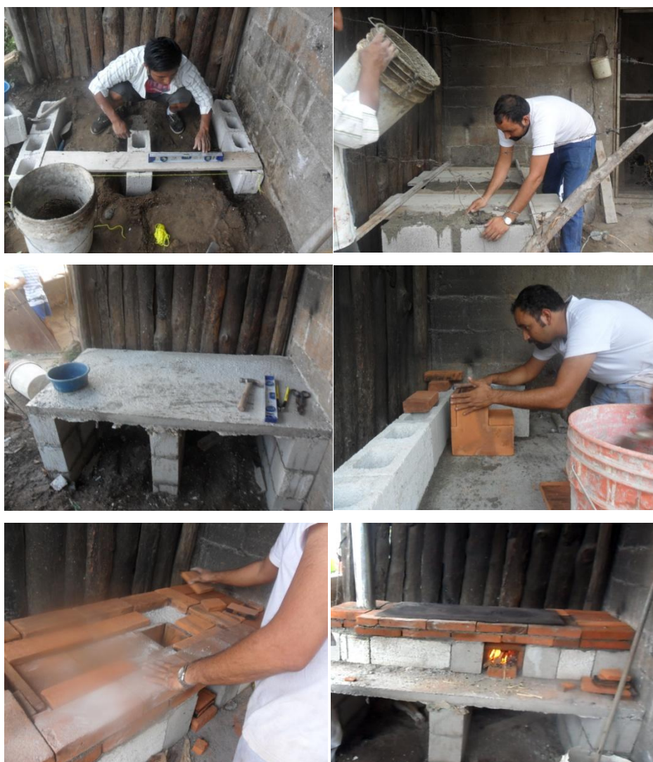
Instalación de una estufa
