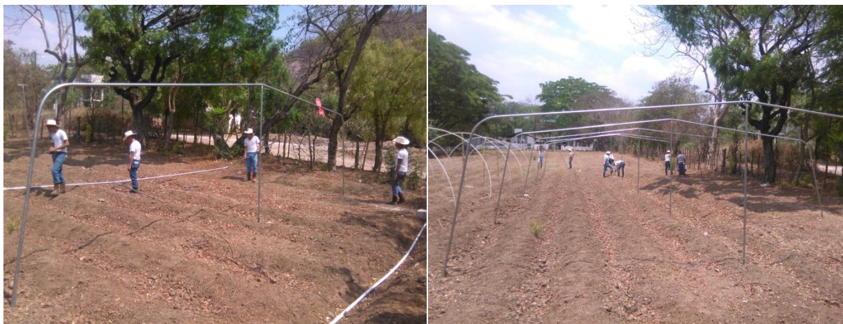
Estructura de hierro galvanizado del macrotúnel
