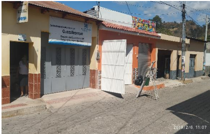
Vista del exterior de la Subdelegación Municipal de Registro de Ciudadanos, donde se realizó el diagnóstico institucional.
