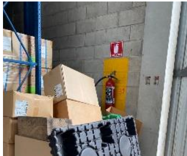
Figura 43. Extintor obstruido en textiles
