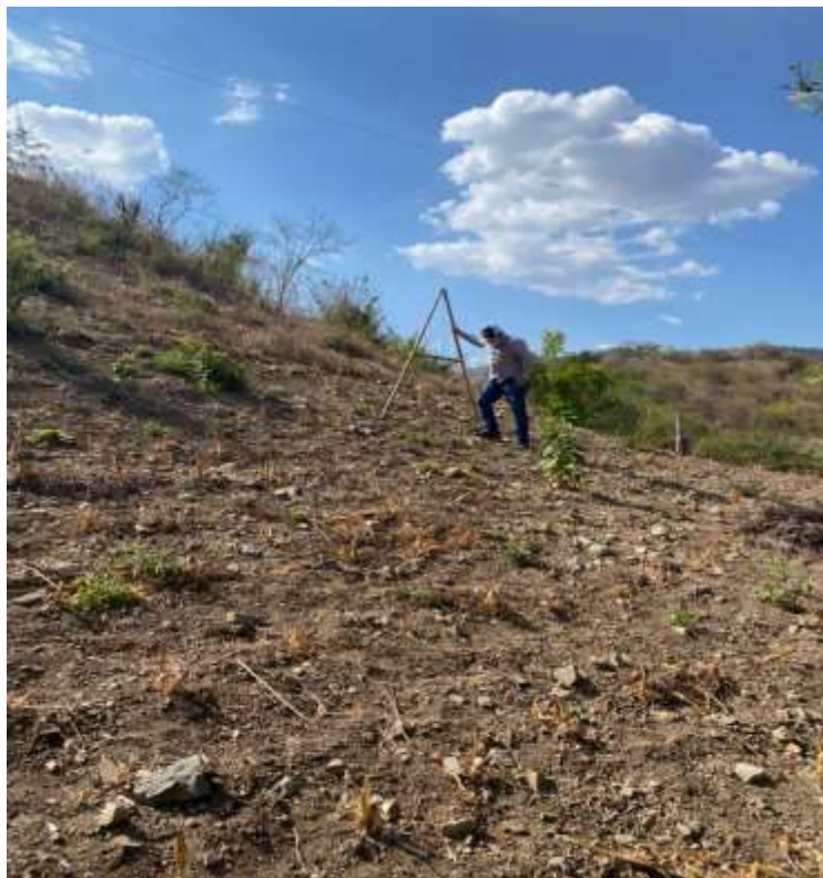
Fotografía 4. Elaboración de nivel en A.
