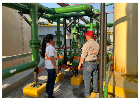
Toma de muestra de agua en ptar
