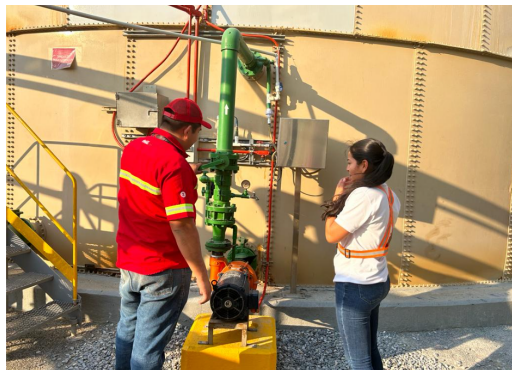
Toma muestra de agua en PTAR
