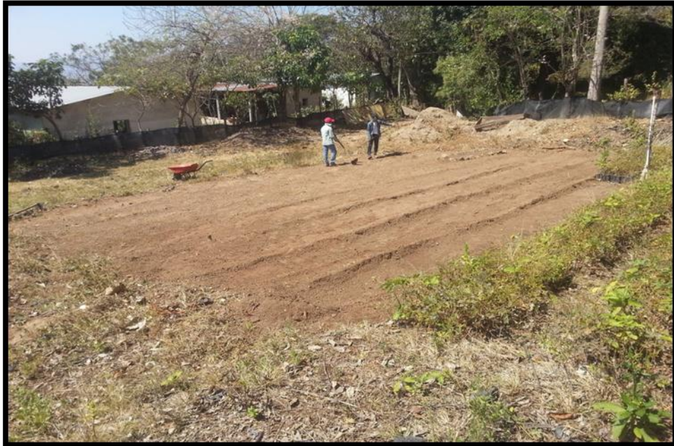
Fotografía 1: Limpieza del terreno
