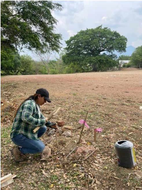
Fotografía 3. Alineación con varillas para el cercado del vivero.
