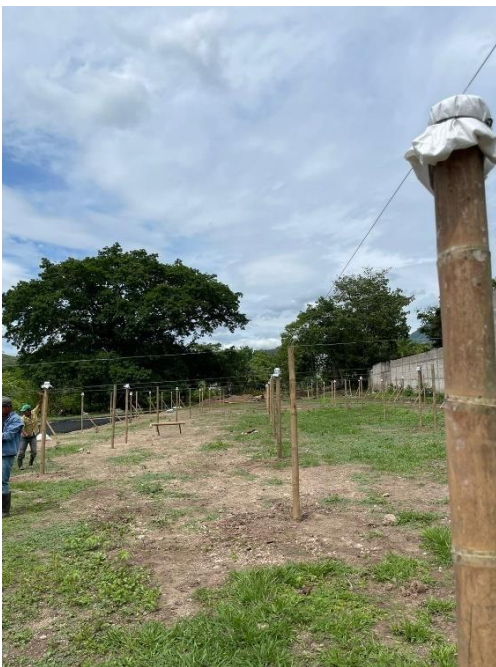
Fotografía 5. Colocación de postes para el vivero.
