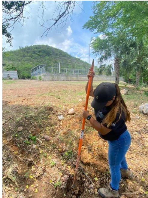
Fotografía 4. Perforación para la inserción de los postes para el vivero.
