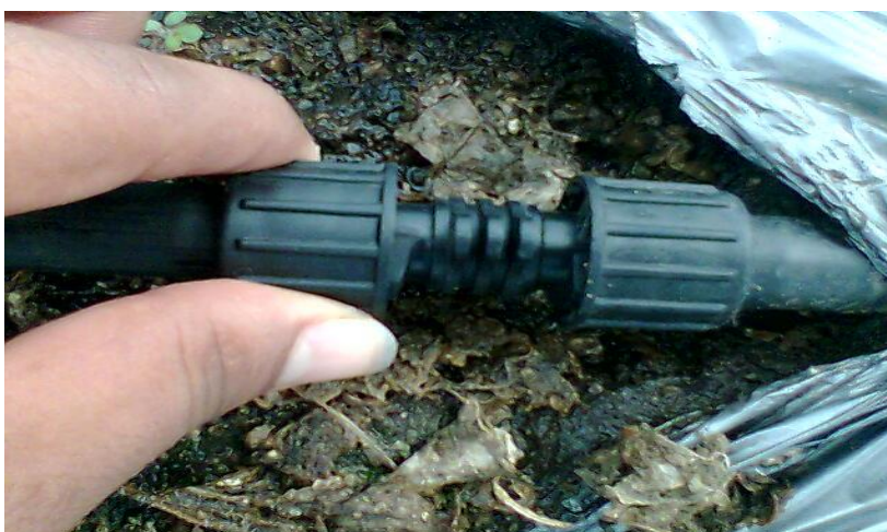
Figura 3. Colocación de conectores para evitar fugas de agua, Frudex, 2007.
