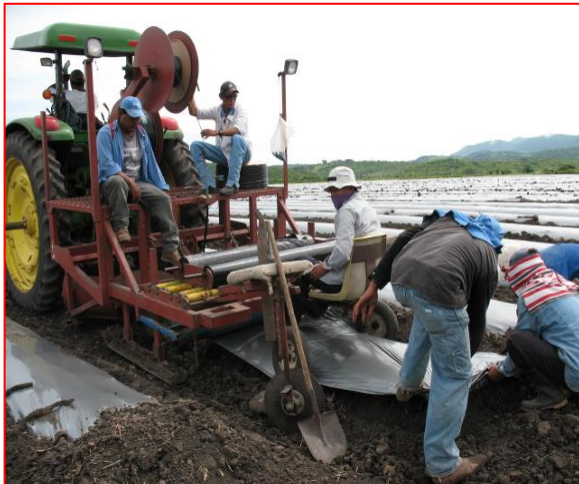
Fig. 13 Proceso de emplasticado y colocación de la manguera de riego.
