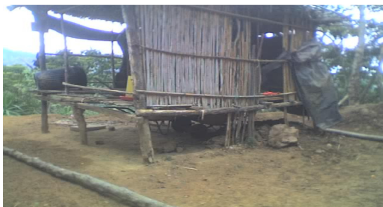
Foto A5. Construcción del módulo de aves de postura.
