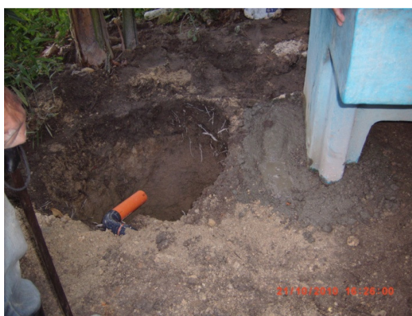
Foto A14. Sifón y conectado para sumidero.
