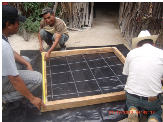
Foto A15. Armazón para tapadera del sumidero.
