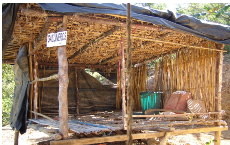
Foto A4. Construcción del módulo de aves de postura.
