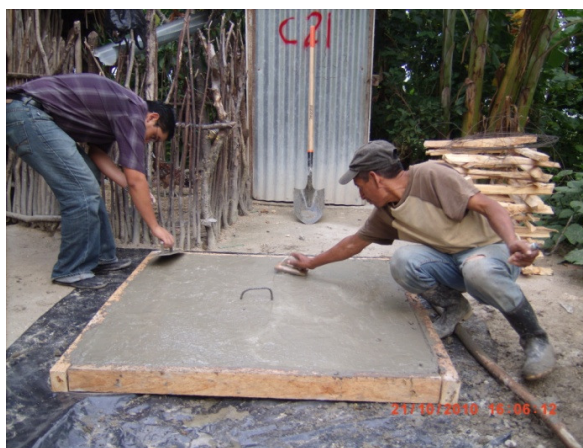
Foto A16. Tapadera para sumidero
