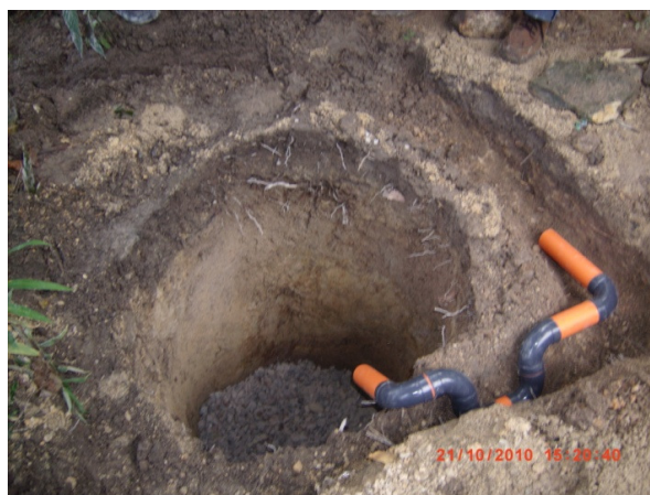
Foto A13. Agujero para sumidero de aguas residuales.
