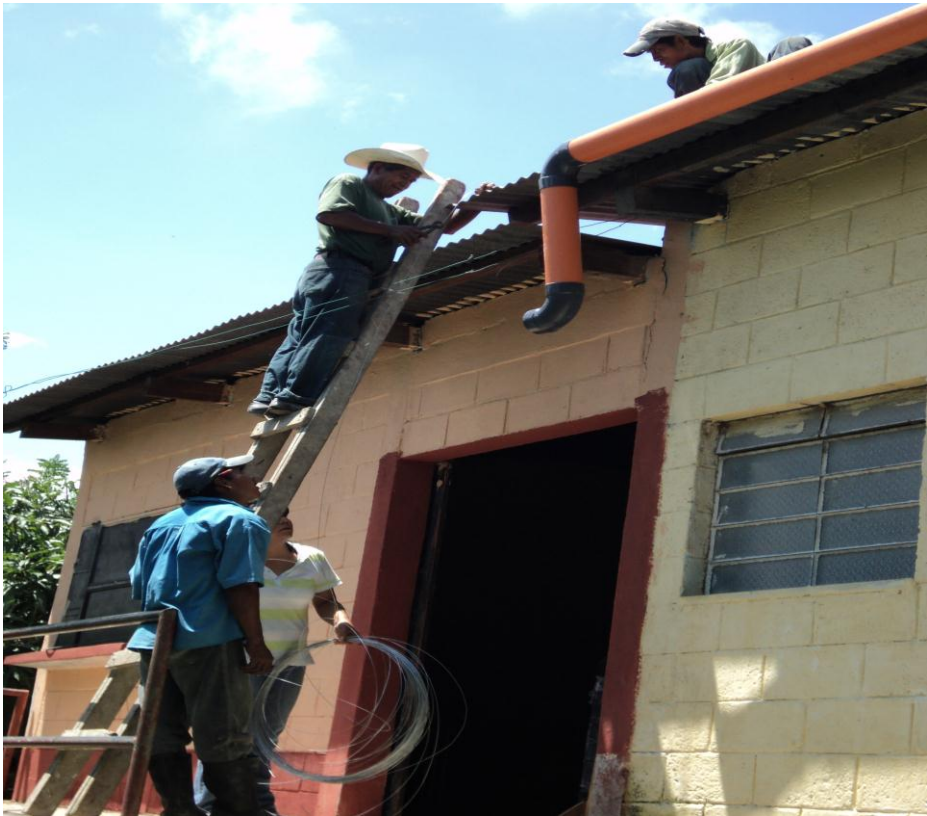
Anexo 5. Instalación de sistema de captación de agua de lluvia.
