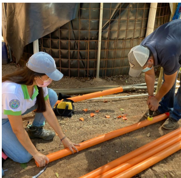
Fotografía 3. Se taladraron los tubos PVC pluvial de 2", en la comunidad de Plan, Tierra Blanca, Jocotán.
