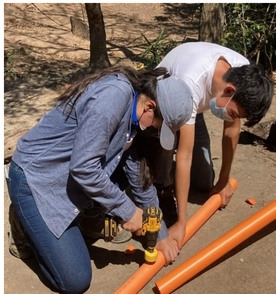
Fotografía 2. Se taladró la guía de los tubos PVC pluvial de 2", en la comunidad de Toma de Agua, Camotán.
