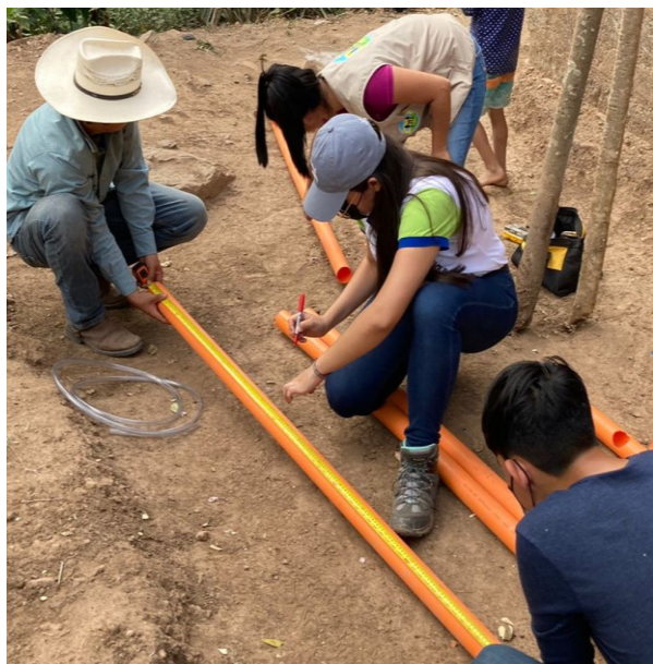
Fotografía 1. Medición de tubos de PVC pluvial de 2", en la comunidad de Barrio Nuevo, Tierra Blanca, Jocotán.
