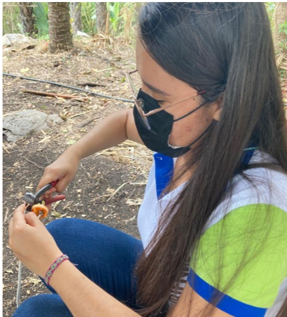
Fotografía 15. Elaboración de extensión para instalación de paneles fotovoltaicos, en la comunidad del Roblar, Camotán.
