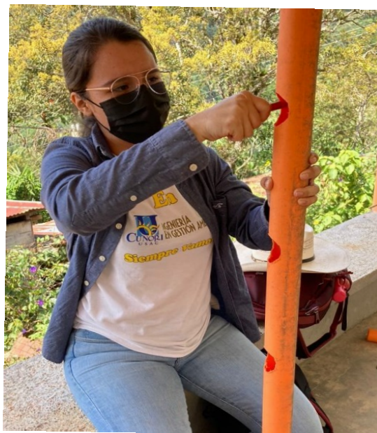
Fotografía 4. Se limpian los agujeros de los tubos de PVC pluvial de 2", en la comunidad de Barbasco Talquezal, Jocotán.
