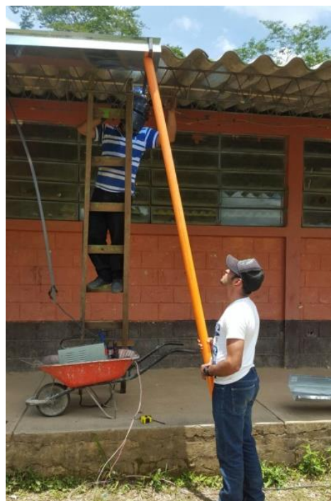
Figura 10: Instalación de canales para captación de agua de lluvia en la escuela de la comunidad de Churischán, San Juan Ermita.
