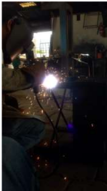
Figura 43. Soldadura de estructura
