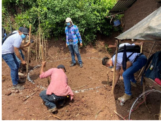
Fotografía 2. Construcción de los scall
