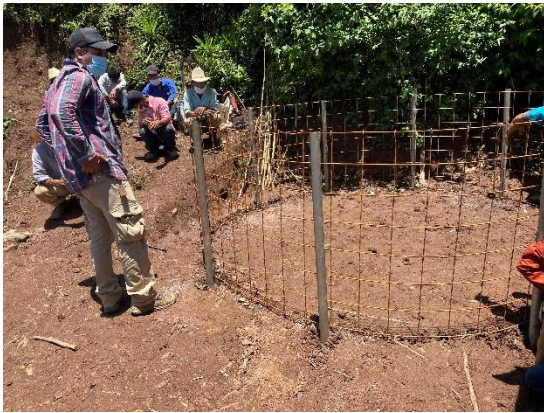
Fotografía 1. Construcción de los scall
