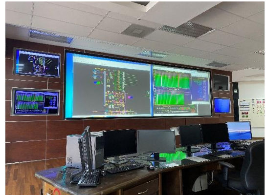
Imagen 12. Sistema SCADA.
