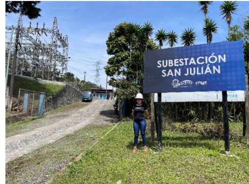
Imagen 15. Estudiante EPS GAL en la Subestación Eléctrica San Julián.
