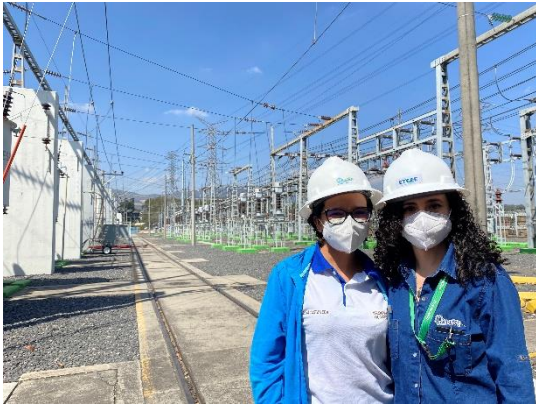
Imagen 11. Encargada de Ambiente y Estudiante IGAL en subestación Guatemala Sur.
