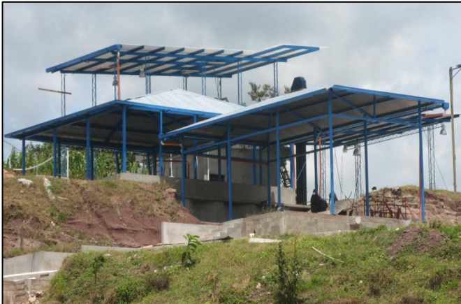
Figura 1. Instalaciones Beneficio Húmedo.
