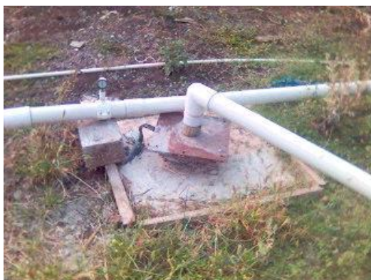
Pozo con bomba de 7 caballos de fuerza y cajas de control
