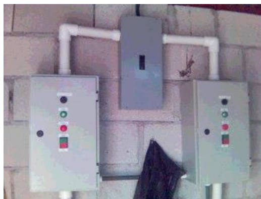
Pozo con bomba de 7 caballos de fuerza y cajas de control
