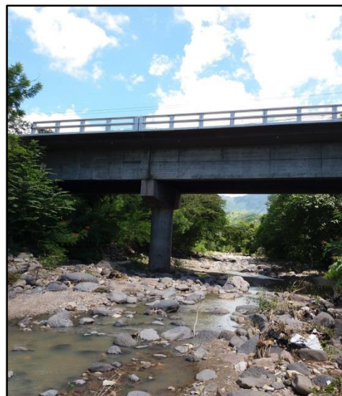
Fotografía 15: Material constitutivo: Hormigón Años de construido: Más de 20 años Puente río Petapilla, aldea Petapilla, 2016.
