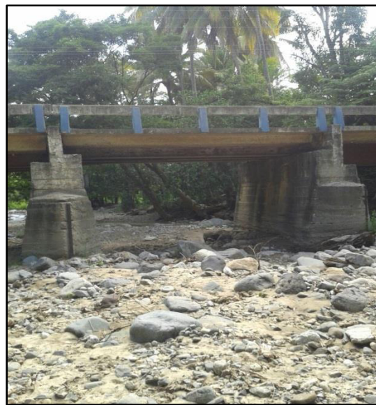
Fotografía 21 Material constitutivo: Hormigón Años de construido: Más de 20 años Puente Shusho, aldea Shusho Arriba, 2016.
