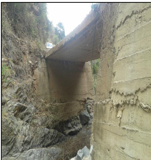
Fotografía 22 Puente El Carrizal, aldea El Carrizal, 2016. Longitud: 10 - 20 Mts. Ancho: 0 – 5 Mts
