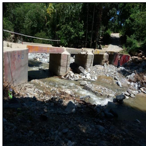
Fotografía 19 Material constitutivo: Hormigón Años de construido: Más de 20 años Puente Shusho Arriba, aldea Shusho Arriba, 2016.
