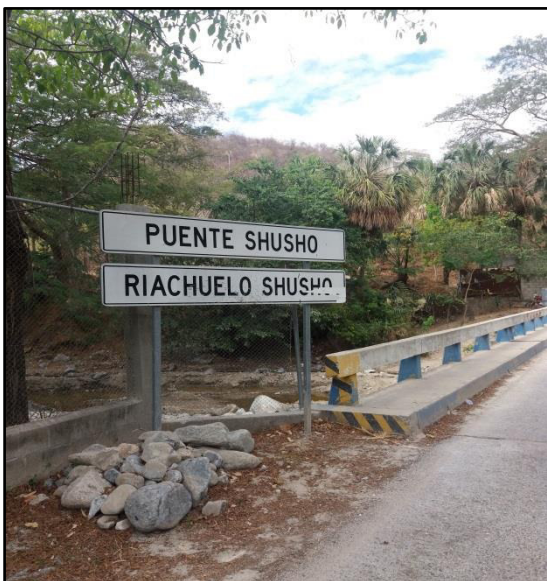
Fotografía 20 Puente Shusho, aldea Shusho Arriba, 2016. Longitud: 20 – 40 Mts. Ancho: 5 – 10 Mts.
