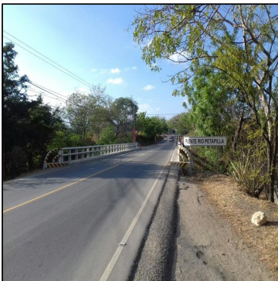
Fotografía 14: Puente río Petapilla, aldea Petapilla, 2016. Longitud: 20 – 40 Mts. Ancho: 5 – 10 Mts
