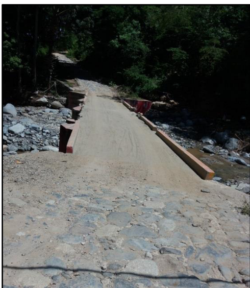
Fotografía 18 Puente Shusho Arriba, aldea Shusho Arriba, 2016. Longitud: 20 - 40 Mts. Ancho: 0 – 5 Mts
