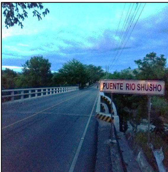
Fotografía 12: Puente río Shusho, aldea Petapilla, 2016. Longitud: > 40 Mts. Ancho: 5 – 10 Mts.
