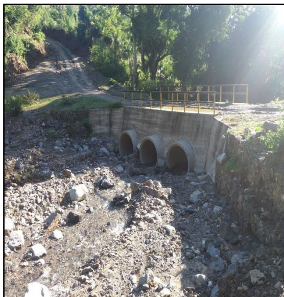
Fotografía 17 Material constitutivo: Hormigón Años de construido: 10 – 20 años Puente Los Felipe, aldea El Palmar, 2016.
