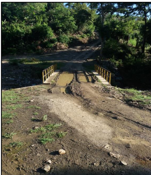
Fotografía 16 Puente Los Felipe, aldea El Palmar, 2016. Longitud: 10 – 20 Mts. Ancho: 0 – 5 Mts.
