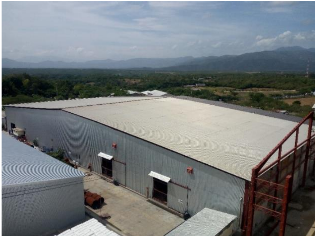
Figura 20. Edificio de la línea de conversión de higiénicos
