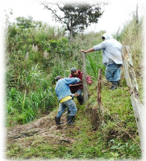
Reparación de cercos dañados
