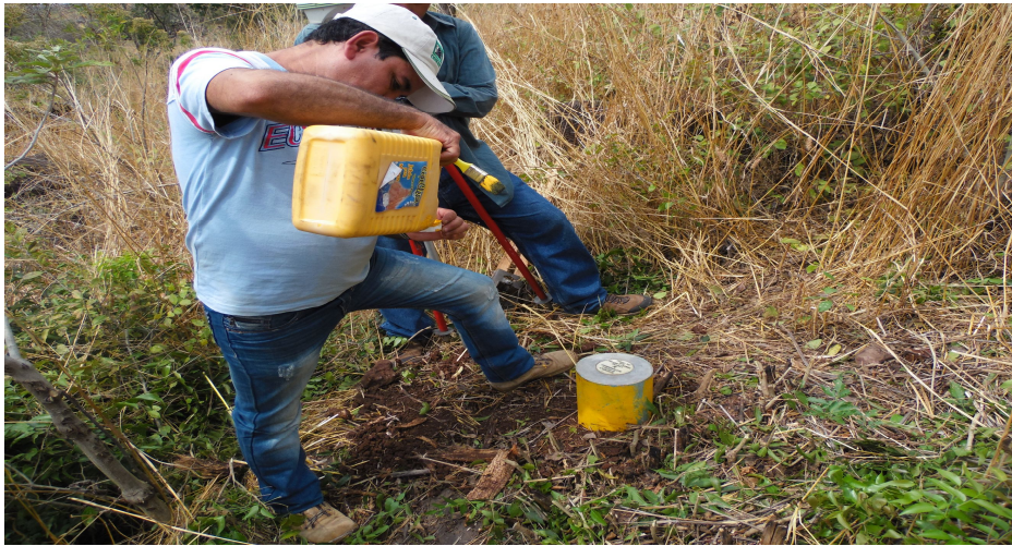
Técnico Gerson Gudiel del Registro de Información Catastral realizando retoque de pintura a mojón con daño superficial por traslado.
