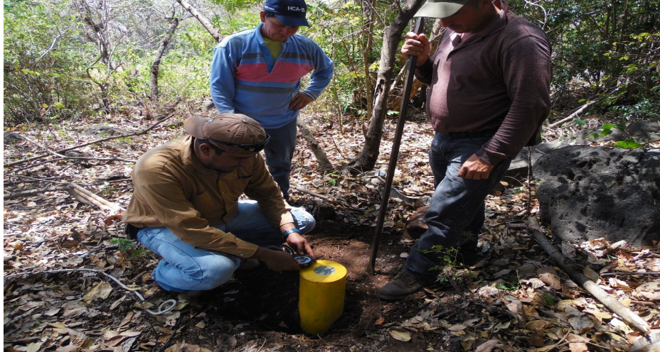
Técnico del Registro de Información Catastral Melvin Jarquin en actividad de colocación y ajuste de mojón
