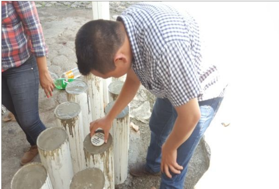
Fundición de mojonos en formaletas de concreto y colocación de fichas de mármol
