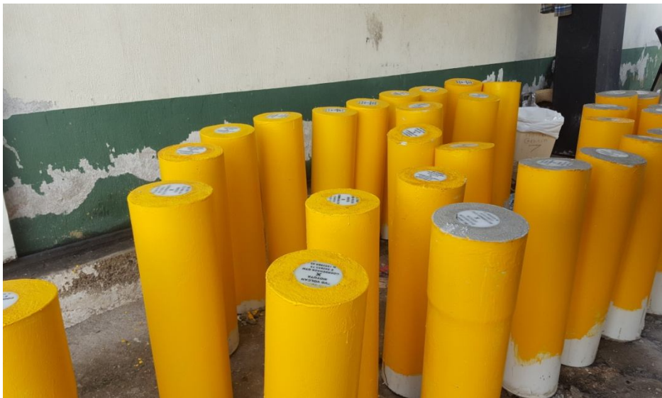
Aplicación de pintura color amarillo a estructuras fundidas
