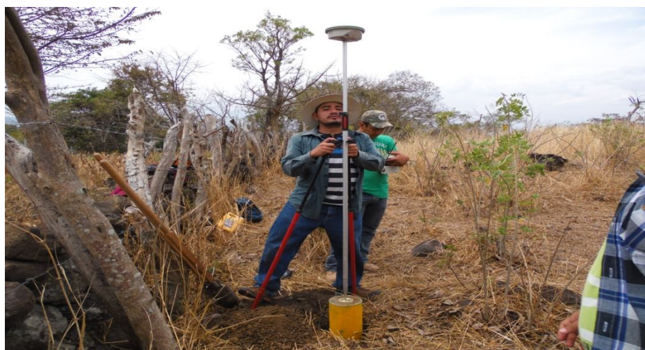
Replanteo y demarcación de vértices del perímetro del área protegida Área de Uso Múltiple Volcán y Laguna de Ipala
