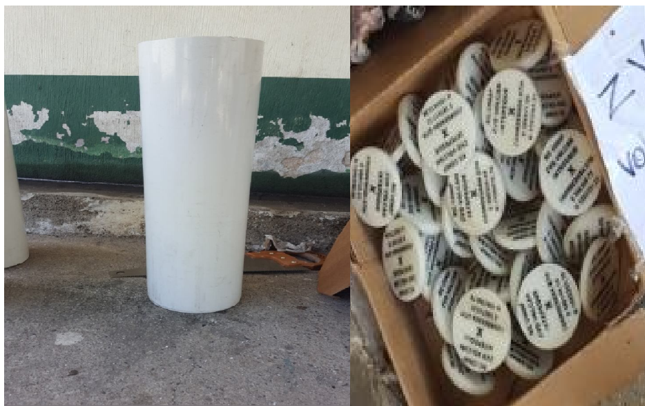
Formaleta y fichas de mármol para la construcción de mojones a demarcar
