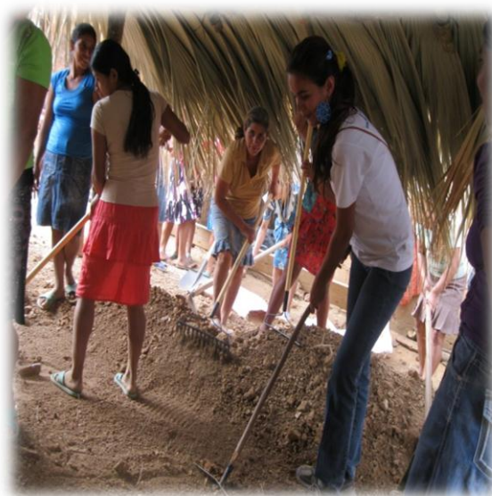
Fig. 1. Construcción de Galpón.
