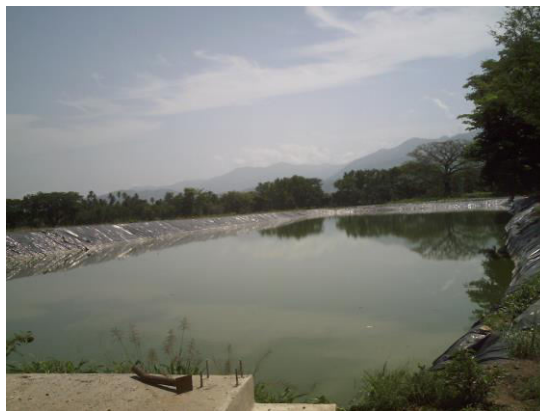
Figura 1. Reservorio de FRUDEX S.A. con capacidad de almacenaje de 5000 metros cúbicos.
