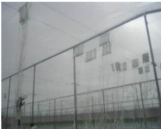
Figura 3. Colocación de tutores
