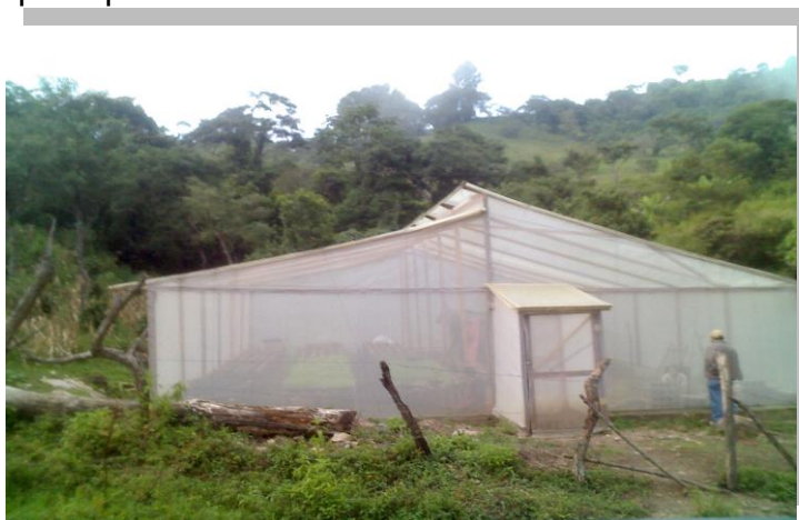
Figura 3. Invernadero de estructura Semi – tecnificada, tipo capilla (dos aguas), 500 m2. Propietario Rene Guevara, Olopa.
