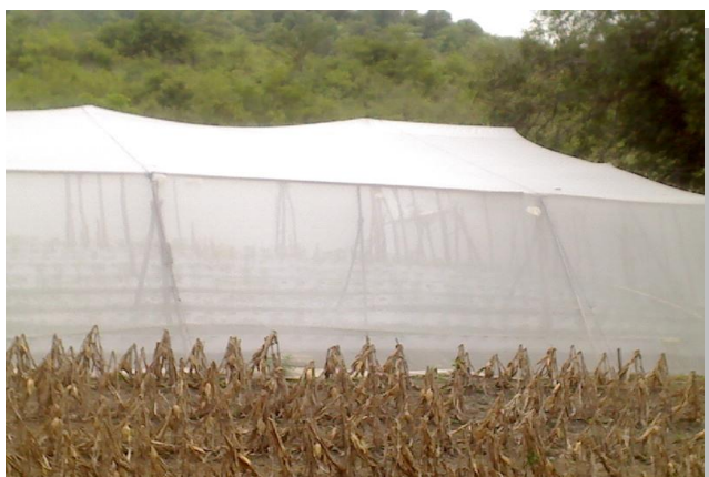
Figura 4. Casa Malla con estructura semi tecnificada, tipo capilla. Propietario Edwin Cerón Soto, Hacienda El Santo, Chiquimula.
