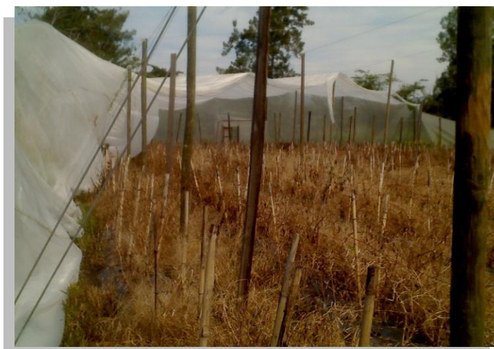
Figura 7. Casa malla destruida por acción de fuertes vientos. Propiedad de Saúl Giron, Ipala, Chiquimula.
