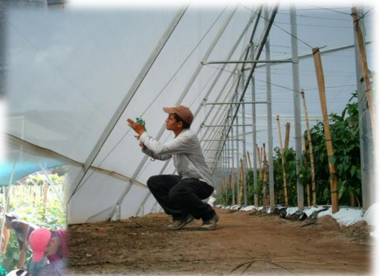
Reparación de malla antiáfidos
