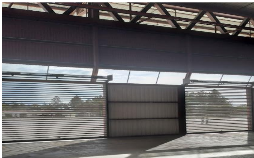
Figura 31. Entradas de aire en el área de conversión
