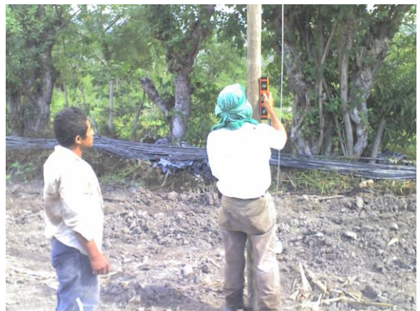
Fig. 25. Colocación y nivelación de postes.
