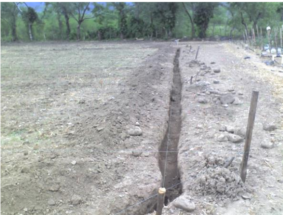
Fig. 22. Trazado y zanjeado.
