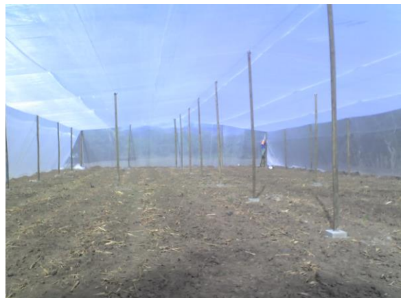
Fig. 31. Tensado de cables.
