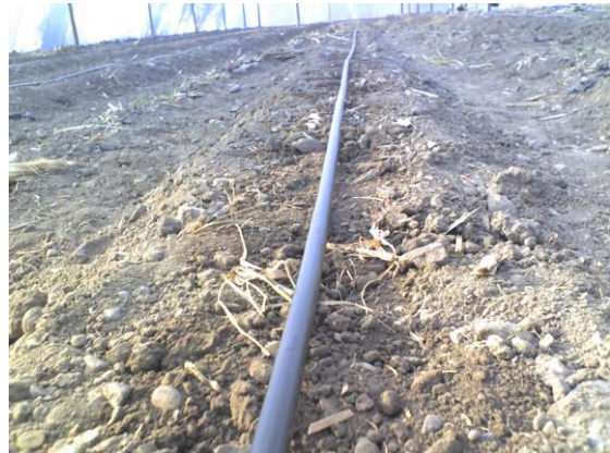
Fig. 36. Colocación de manguera.
