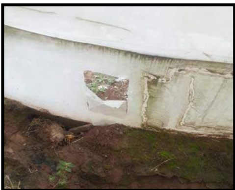
Anexo 5. Orificios los cuales eran reparados con parches e hilo de nylon.
