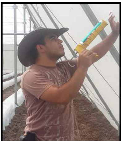
Anexo 4. Tapado de orificios en las paredes de la casa malla.
