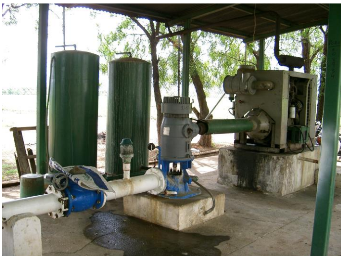
COMPONENTES DE ESTACION DE BOMBEO (FILTROS, MOTOR, MANOMETRO)
