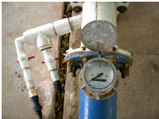
COMPONENTES DE ESTACION DE BOMBEO (FILTROS, MOTOR, MANOMETRO)
