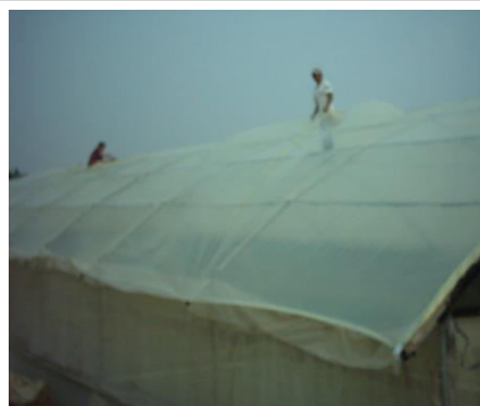
b. Colocación y estiramiento del nylon
