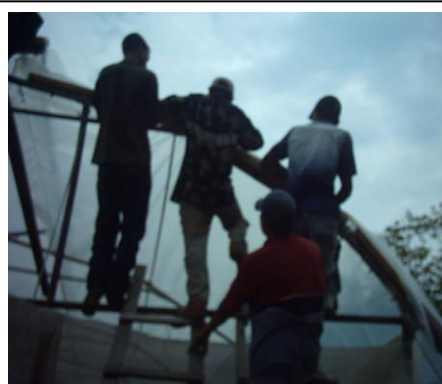
b. Colocación y estiramiento del nylon
