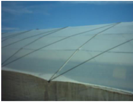
e. Cubierta de nylon estirado (parte de afuera del Invernadero)
