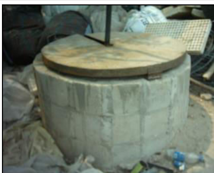
Figura 3. Pozo Perforado manualmente (17.55 mts)
