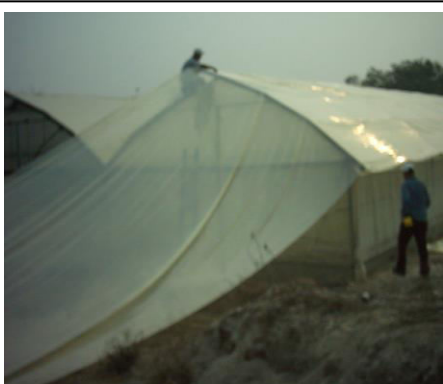
b. Colocación y estiramiento del nylon
