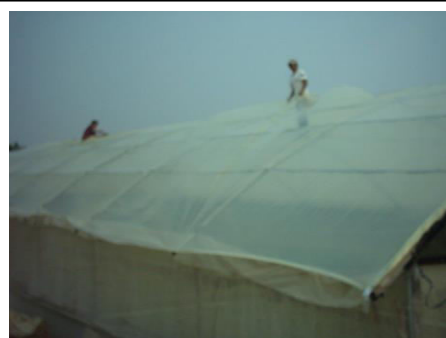
e. Cambio de cubierta de nylon en el techo
