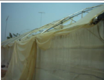
e. Cambio de cubierta de nylon en el techo
