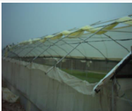
a. Colocación del nylon en la parte más alta del invernadero
