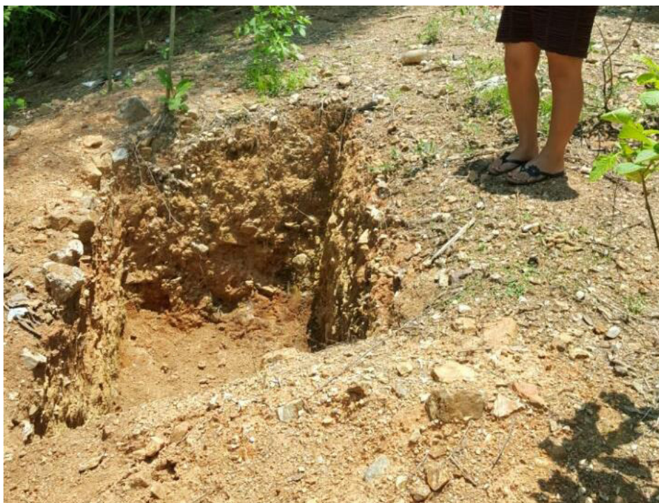
Fotografía 6. Pozo de infiltración de 1m 3 .
