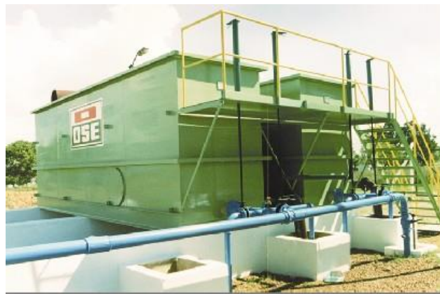
Figura 6: Sistema de potabilización UPA 200T
