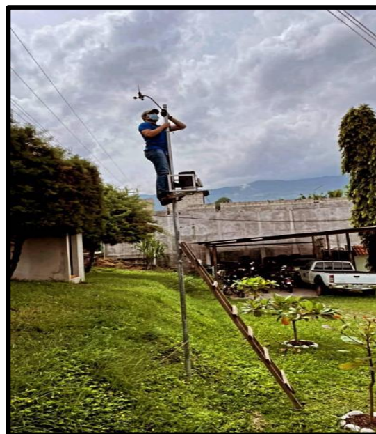
Foto 8. Instalación de estación meteorológica en ASORECH, Quezaltepeque.
