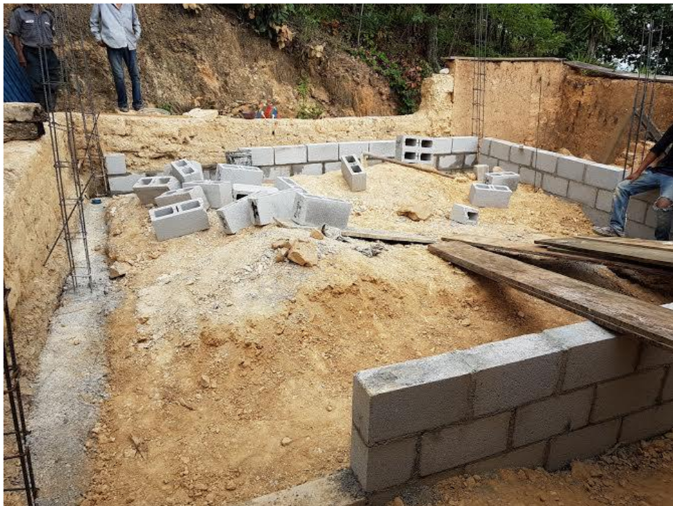
Figura 13A: Construcción e instalación del equipo del galpón.
