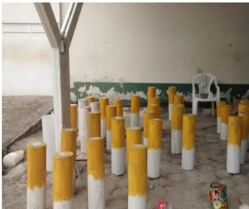
Se aplicó pintura amarilla en las formaletas fundidas.
