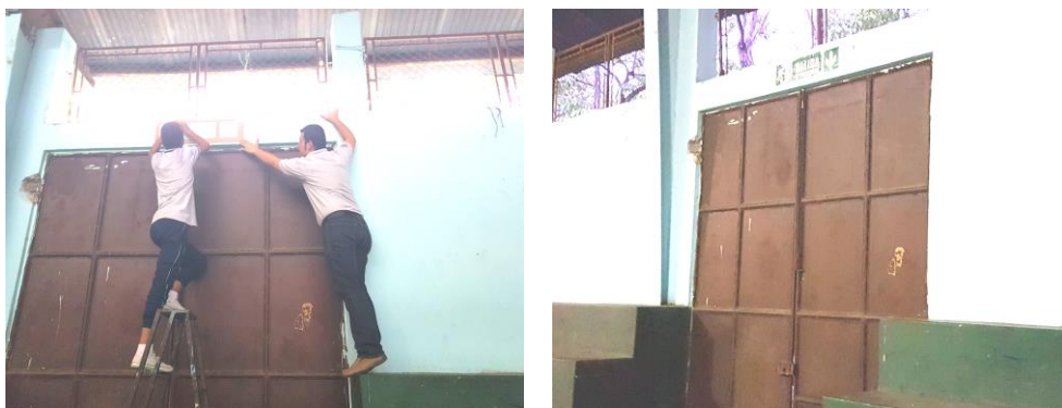
Realizando la señalización de las rutas de evacuación en el establecimiento según lo establecido en la NRD2. // Rutas de evacuación finalizadas.
