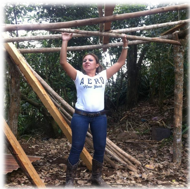
FIGURA 5 CONSTRUCCIÓN DE LAS BASES DEL GALPÓN DEL PROYECTO DE INSTALACIÓN DE GALPONES DE GALLINAS CRIOLLAS
