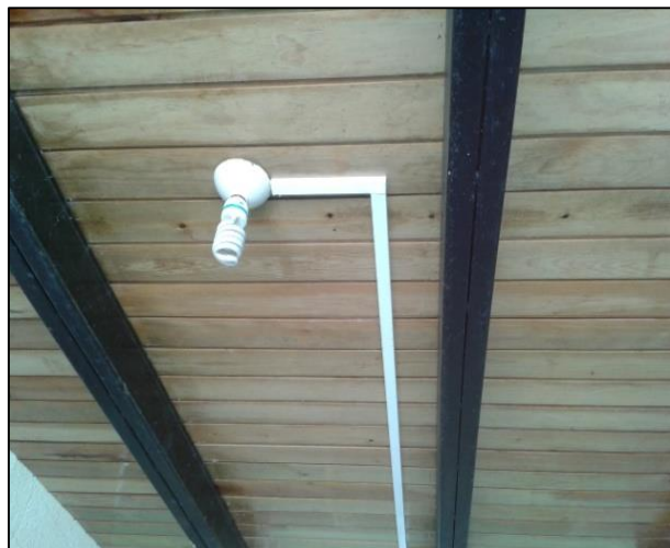
Fotografía 2. Inspección y realización de inventario de luminarias.
