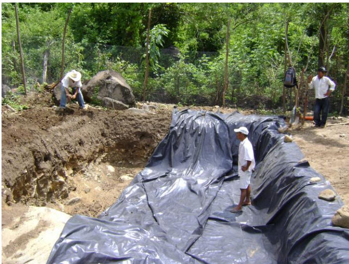
Figura 7. Construcción de estanque para la producción la tilapia, en la comunidad de Los Ramírez.
