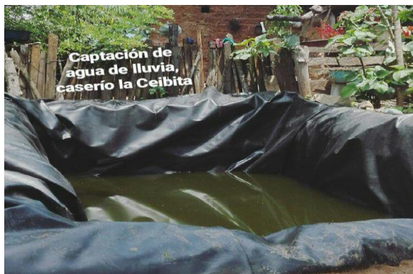
Figura 8. Implementación de reservorios de agua de lluvia, caserío la Ceibita, San Pedro Pínula, Jalapa.
