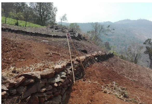
Figura 3. Estructuras de conservación de suelos, barreras muertas, aldea el Chucte, San Diego, Zacapa.
