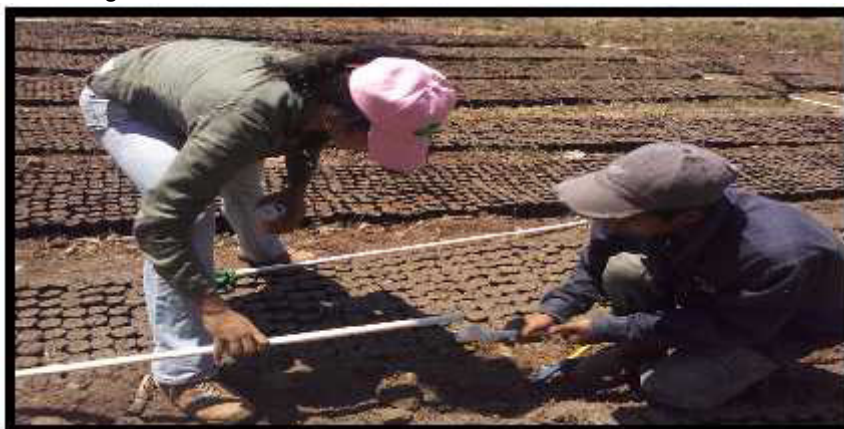
Fotografía 3: Instalación de sistema de riego, vivero forestal.
