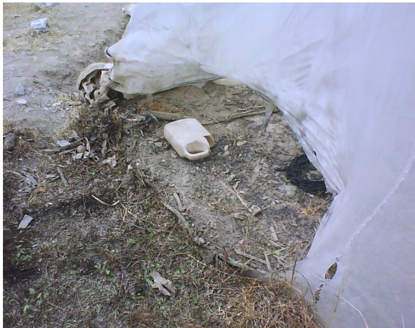
Figura 4. Daños en la estructura de la Casa Malla del Instituto “Adolf V. Hall” de Chiquimula.
