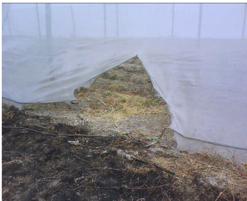
Figura 5. Daños en la casa malla provocados por incendio.
