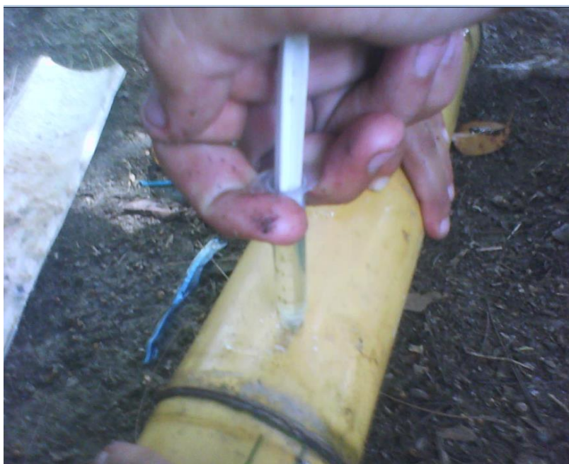
Figura 10. Aplicación de mezcla de diesel y aceite para el curado de las bases de bambú.
