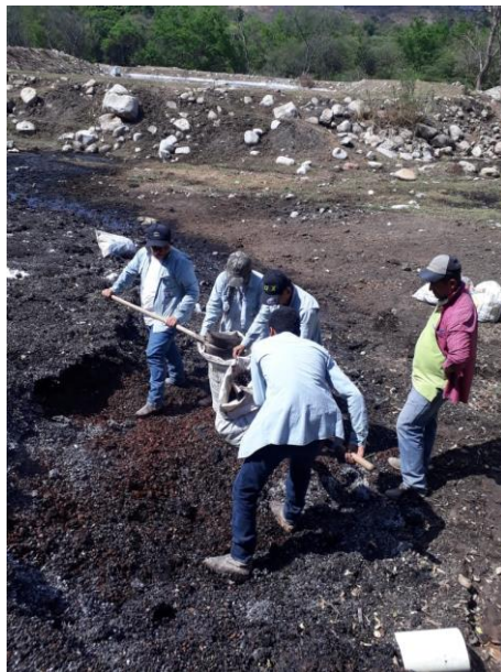
Figura 14. Construcción de aboneras orgánicas
