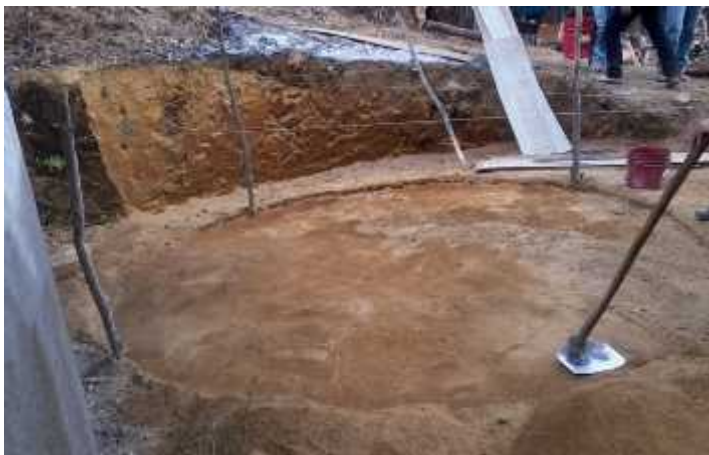
Figura 5. Ilustración de la nivelación en el área definitiva para establecer el sistema de captación, se recomienda estar cerca del área de captación (lámina del techo).
