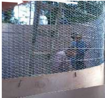
Figura 13. Ilustración del engrosamiento en diámetro, es decir aumenta a 3.84, ya que la dimensión mínima de cada plancha es de 2.26. Forzosamente se usan dos planchas de malla de 2.25 x 6.00
