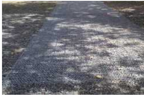
Figura 7. Ilustración de la armadura de electro malla unidas y preparadas.
