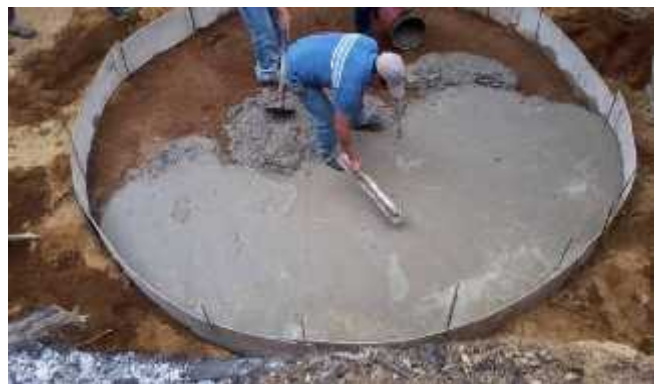
Figura 10. Ilustración de encofrado, nivelado y colocación de guías para la fundición de la base.
