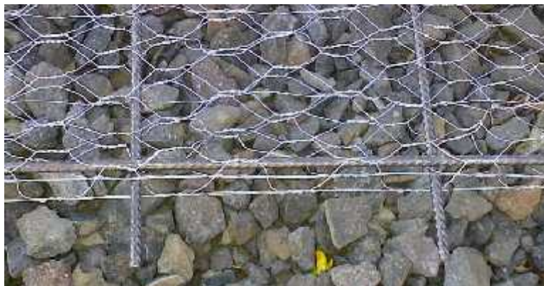
Figura 8. Ilustración del entorchado de la malla de gallinero.
