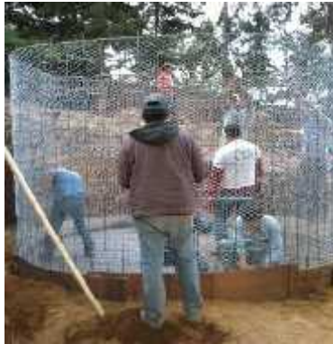
Figura 12. Ilustración de cómo se da la forma cilíndrica al reservorio de agua.
