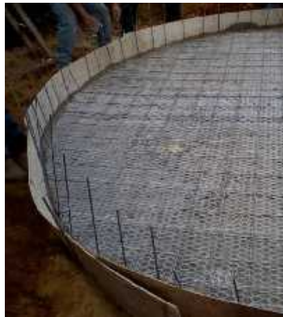
Figura 11. Ilustración de armadura de base colocada sobre primera capa de concreto
