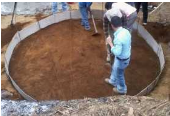
Figura 10. Ilustración de encofrado, nivelado y colocación de guías para la fundición de la base.
