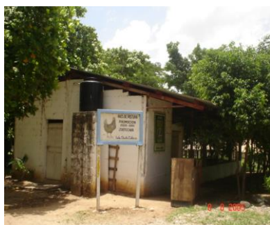
Figura 2. Instalación para gallinas de postura.
