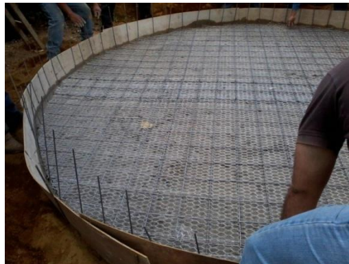
Figura 9. Ilustración de armadura de base colocada sobre primera capa de concreto
