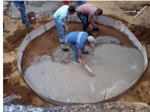
Figura 8. Ilustración de encofrado, nivelado y colocación de guías para la fundición de la base.
