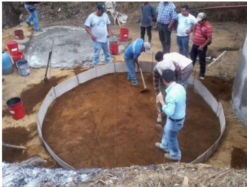
Figura 8. Ilustración de encofrado, nivelado y colocación de guías para la fundición de la base.
