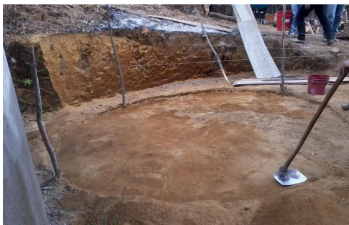
Figura 3. Ilustración de la nivelación en el área definitiva para establecer el sistema de captación, se recomienda estar cerca del área de captación (lámina del techo).
