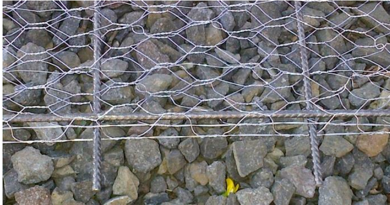
Figura 6. Ilustración del entorchado de la malla de gallinero.
