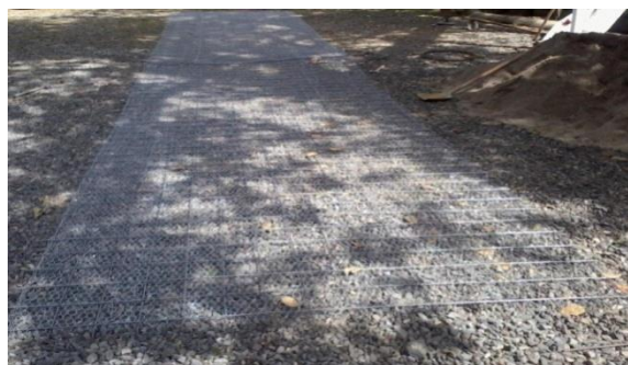
Figura 5. Ilustración de la armadura de electro malla unidas y preparadas.
