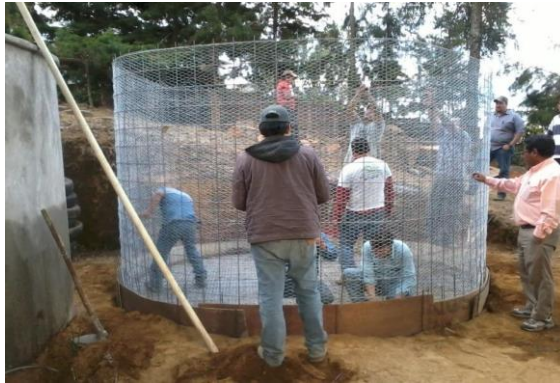
Figura 10. Ilustración de cómo se da la forma cilíndrica al reservorio de agua.
