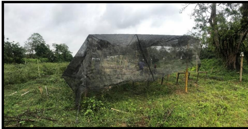
Figura 2. Instalación del sarán en la infraestructura.
