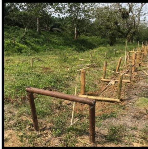
Figura 1. Colocación de las bases para las camas germinadoras.
